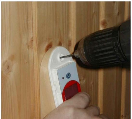
Ar pievienoto pašgriezēju pieskrūvējiet vadības pulti. Izlīdziniet vadības pulti, caur apakšējo vadības pults stiprinājumu izurbiet atveri ar diametru 2-3 mm. Pieskrūvējiet vadības pulti ar pievienoto pašgriezēju.
