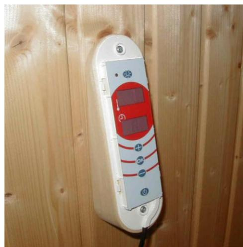
4. Antes de apretar completamente, asegúrese de que el cable serpenteante no está mal colocado entre el controlador y la base de madera, ya que tiene que estar en el hueco destinado a él.
