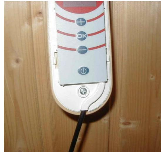
5. Montera styrdonets ram. Ramen kan tryckas på plats för hand. Avlägsna den förbearbetade plastdelen för kabeln i ramens underdel t.ex. med en kniv.
