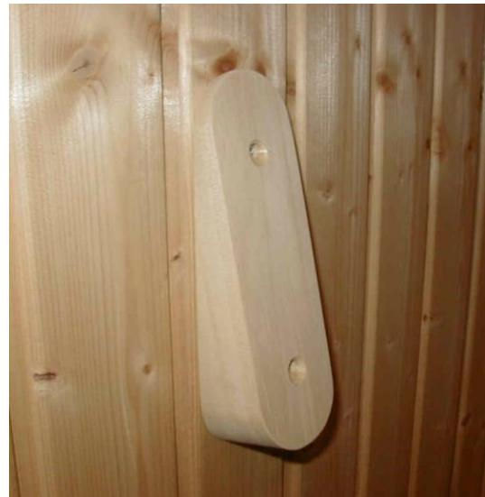
2. Passa in styrdonet så noggrant som möjligt på träunderlägget och borra ett hål på 23mm i underlägget genom det övre ämnet. Hålets djup har ingen betydelse, eftersom avsikten endast är att underlätta skruvens fastsättning i underlägget.
