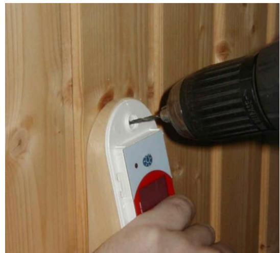
Прикрутите пульт управления прилагающимся саморезом. Выровняв пульт управления, про- сверлите отверстие диаметром 2-3 мм. через нижнее крепление пульта управления. Прикрутите пульт управления прилагающимся саморезом.
