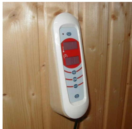
Накладка снимается путем одновременного нажатия маленькой отверткой или другим подходящим предметом на клипсы и затем осторожного снятия накладки.
