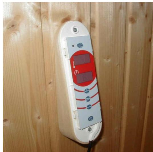
4. Kontrollera före den slutgiltiga åtdragningen att spiralkabeln inte kläms åt mellan styrdonet och underlägget utan ligger i sitt spår.
