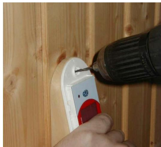
3. Skruva därefter fast styrdonet i underlägget. När du kontrollerat att styrdonet är rakt i förhållande till underlägget, borra ett hål genom den nedre plankan och skruva fast styrdonet även den nedre delen.
