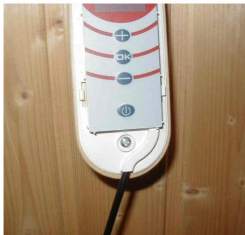
5. Coloque el marco del controlador en su sitio, presionándolo con las manos. Retire con un cuchillo, por ejemplo, la pieza de plástico reservada para el cable.
