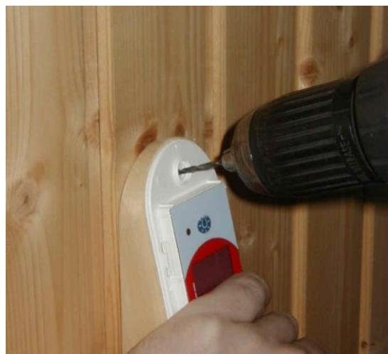
Kinnitage juhtimispult kaasasoleva iselõikuva kruviga. Asetage juhtimispult otse ja puurige läbi alumise kinnituse 2...3 mm läbimõõduga ava. Kinnitage juhtimispult kaasasoleva iselõikuva kruviga.
