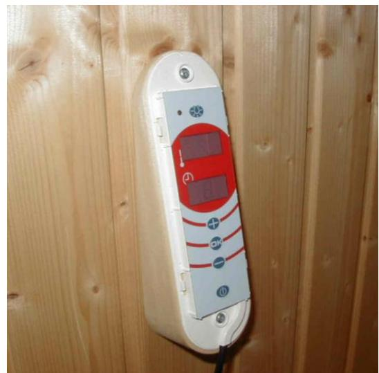
Перед окончательной затяжкой саморезов убедитесь в том, что соединительный кабель расположен в выемке, предназначенной для него, а не зажат между пультом управления и деревянным основанием.
