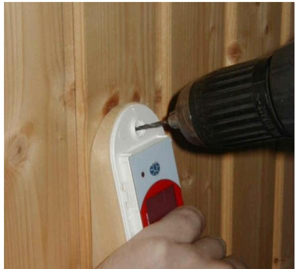
3. Kiinnitä tämän jälkeen ohjain ruuvilla puiseen alustaan. Kun olet varmistanut että ohjain on suorassa alustaan nähdien, poraa reikä alemman aihion läpi ja ruuvaa ohjain kiinni myös alaosasta.
